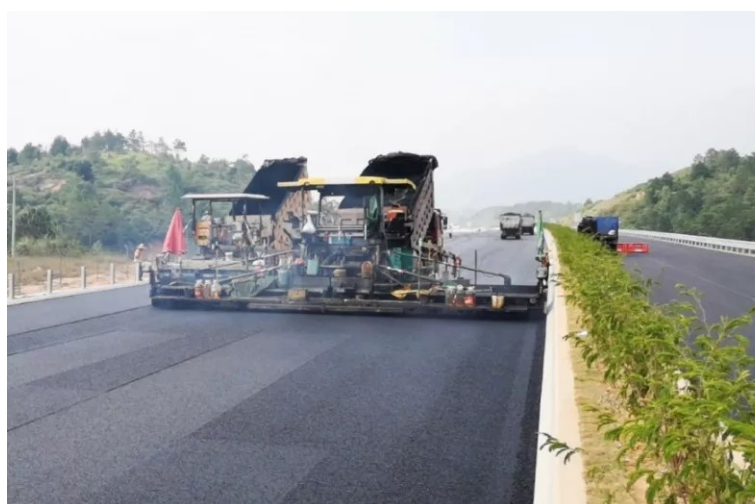
河惠莞高速龙紫段主线沥青路面施工正在收尾 本报记者 郝晓楠 摄
